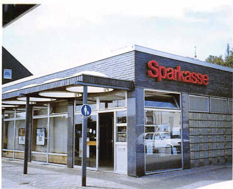
Zweigstelle Oberloh vor dem Umbau, 1996
