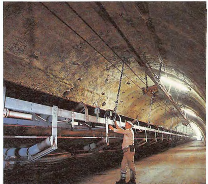
Erbö, Förderbandanlage für die Zeche Prosper-Haniel.
