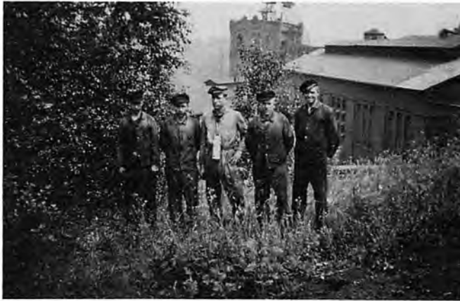
Bergschlosser 1940 auf der Berghalde mit Blick auf das Kesselhaus und Schacht I von Alte Haase.
